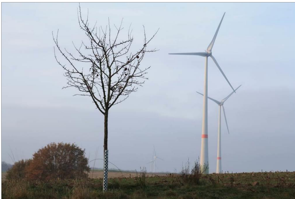
Abbildung 5 Blick auf zwei WEA des Typs Enercon E82 aus einer Entfernung von ca. dem 4 bzw. 5,5 fachen der Anlagenhöhe
